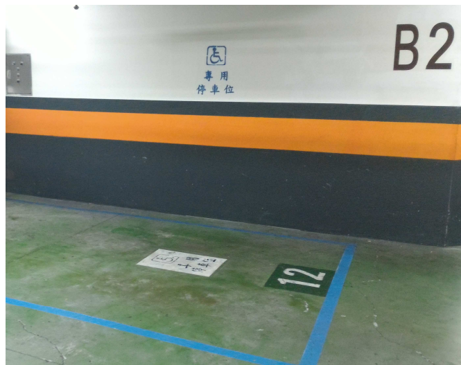
無障礙地下室專用停車位
